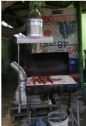
ภาพที่ 4.21 เครื่องดูดควันที่ติดตั้งเรียบร้อยแล้วพร้อมใช้งาน
