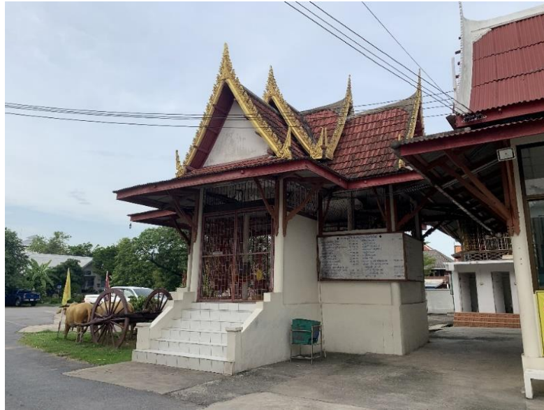
ภาพที่ 4.6 ศาลาประดิษฐานพระสร้างตรงตำแหน่งเมรุเก่า
